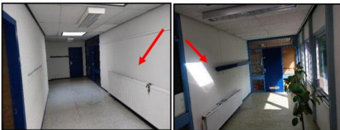
Bron 4: asbesthoudend plaatmateriaal als binnenwand (dubbel als sandwichpaneel).
